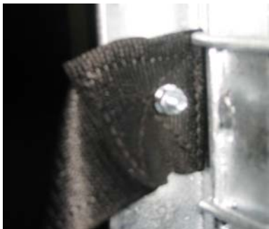
DETALLE UNIÓN CINTA CON PORTICO
