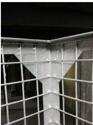
DETALLE SOLDADURA ENTRE MALLA Y PÓRTICO
